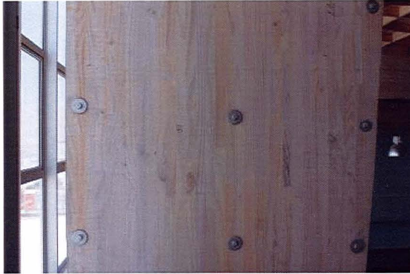
Fotografía 1, Estructura de madera laminada.
