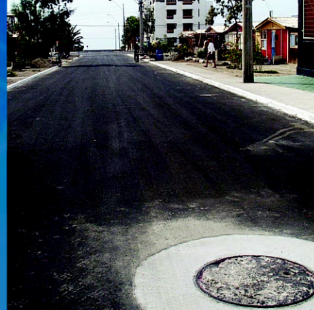
Conservación Vías Urbanas
